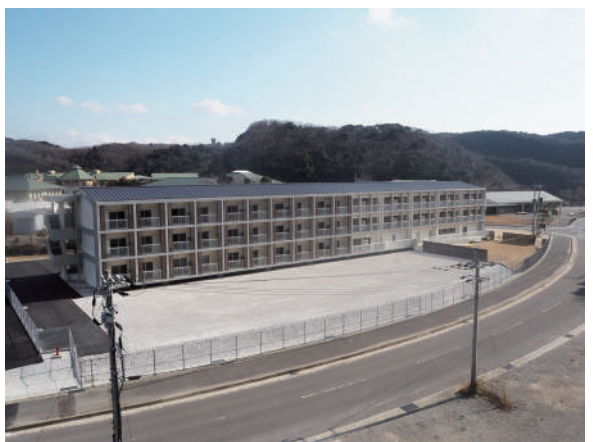
工事実績(対馬病院職員宿舎)
